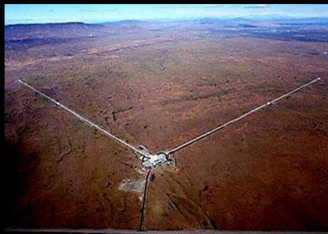
Interferometro laser LIGO USA 2002 Hanford, Livingston Lunghezza bracci 4 km
